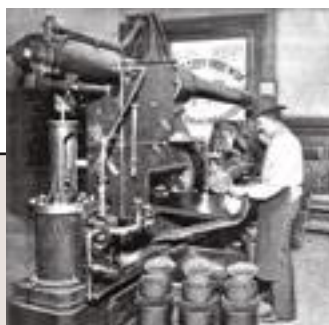
Die Rohrpost im New Yorker Postamt.
